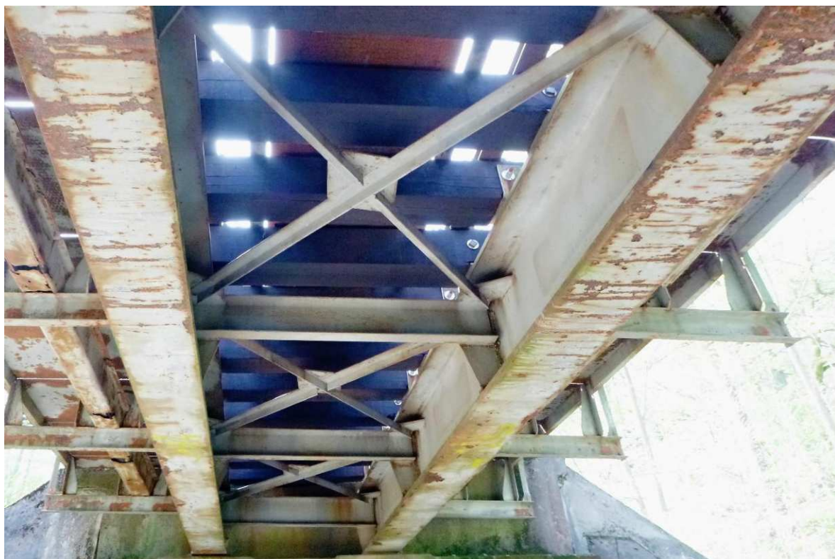
Obrázek 3 Most ev. km 14,617, pohled na ocelovou konstrukci. Ocelová plnostěnná konstrukce s prvkovou mostovkou z r. 1974, navržena k sanaci.
