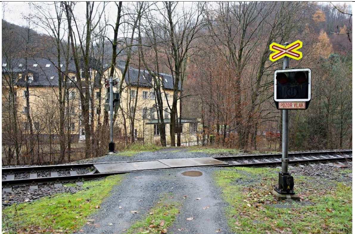
Obrázek 14 Přejezd P7536 s PZS, nezpevněná komunikace k několika chatám. Navržena náhrada přejezdové konstrukce a odvedení vody stékající po cestě mimo přejezd.
