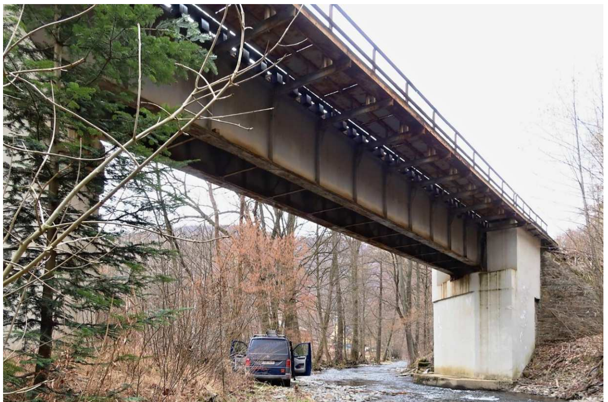
Obrázek 15 Most ev. km 18,449, ocelová trámová plnostěnná konstrukce z r. 1961, navržena k sanaci.
