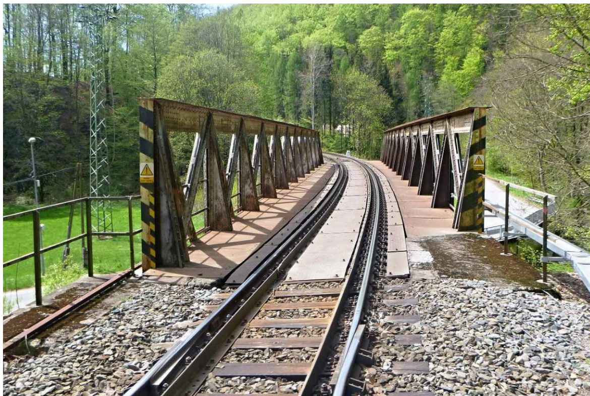
Obrázek 9 Železniční most ev. km 16,647, ocelová příhradová konstrukce z r. 1910, navržena k sanaci.
