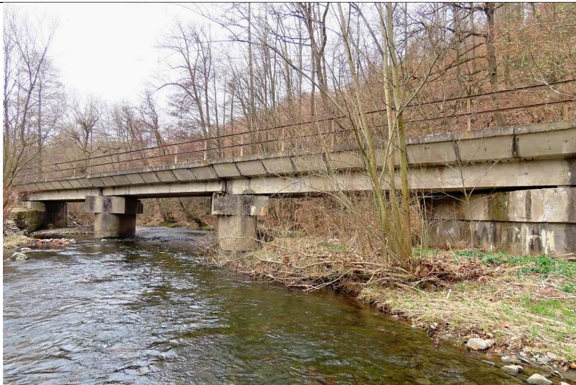
Obrázek 2 Most ev. km 12,897 přes tok Bystřice, pohled zprava. Předpjaté betonové komorové nosníky z r. 1970, tři prostá pole, určen k sanaci.
