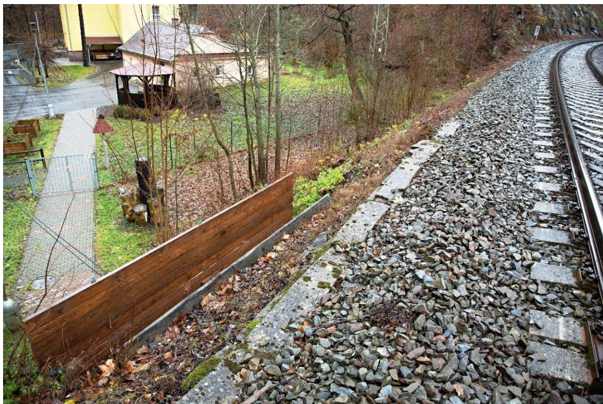
Obrázek 7 Km 16,440, úzký násep, z něž padá štěrk na sousední pozemky a chodník, čemuž brání provizorní zídka z prachů a dřevěné desky.
