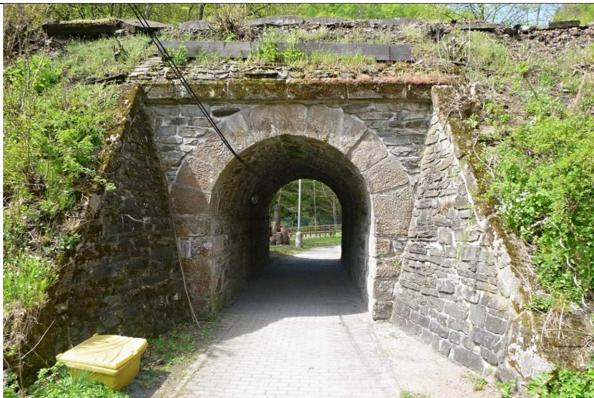
Obrázek 8 Železniční most ev. km 16,440 s kamennou klenbou, nad ním zábrana proti padání štěrku.
