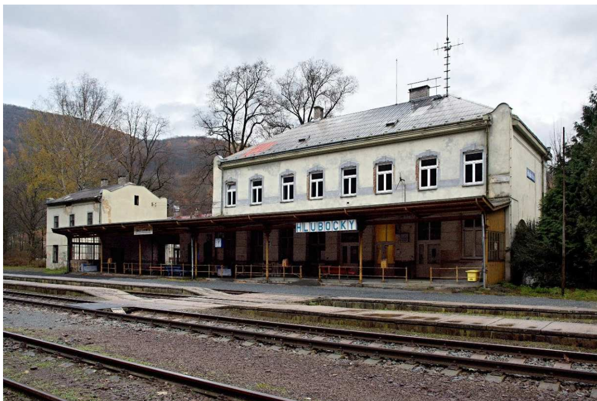
Obrázek 5 Km 14,947, ŽST Hlubočky, budova osobního nádraží s nástupišti. Kolejové lože zanesené drobnou frakcí, v kolejích 2, 3 a 5 pražce SB5.
