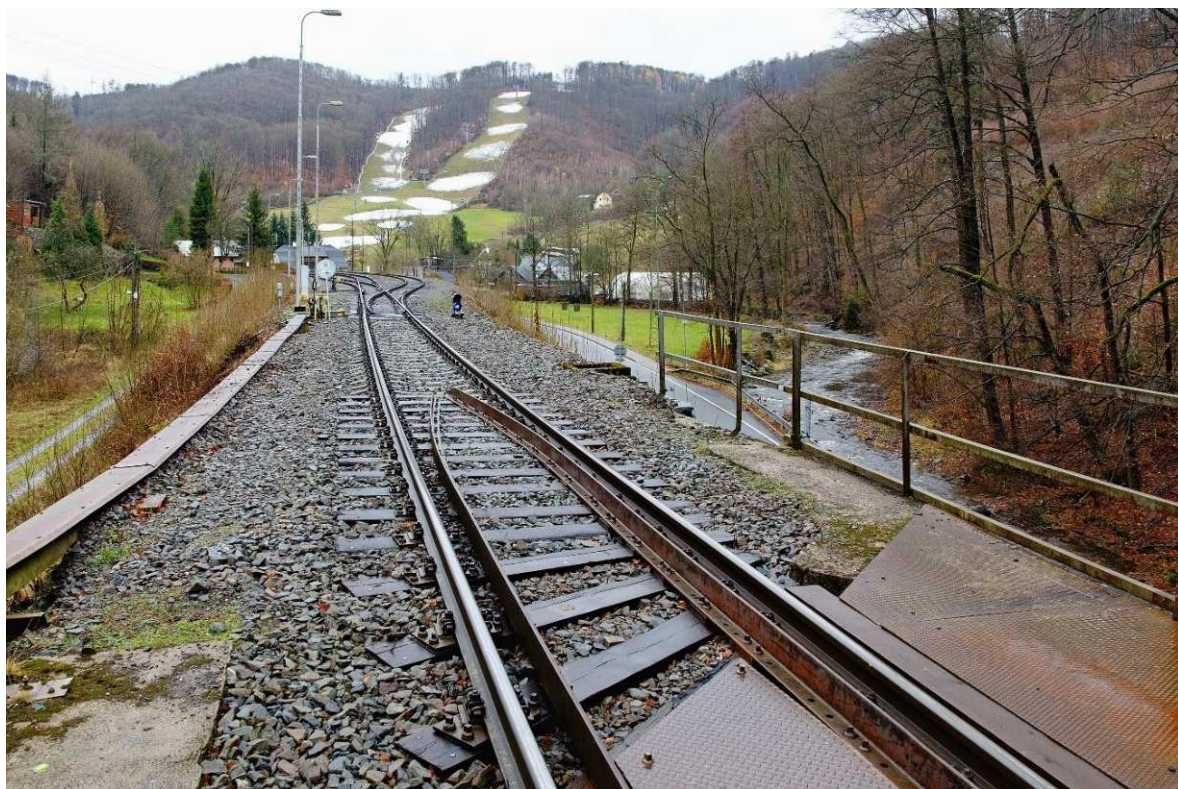
Obrázek 17 Km 18,900, pohled z mostu ev. km 18,902 na hlubočské zhlaví ŽST Hrubá Voda. V přechodové oblasti atypický (šikmý) klad pražců, za nimi dvě výhybky JS49 1:7,5-190.
