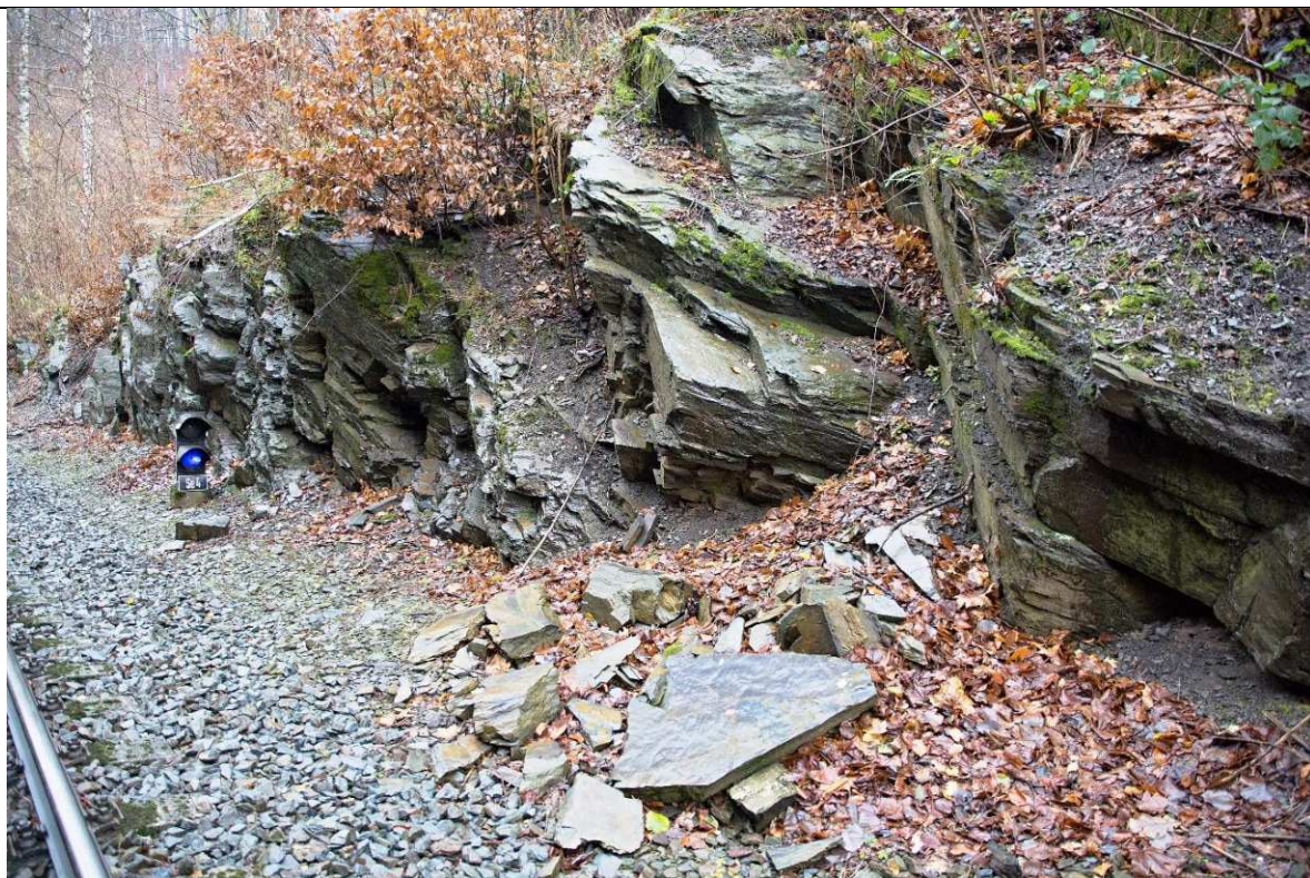
Obrázek 16 Km 18,700, odpadávající kameny ze skalního svahu. Skalní svahy budou ochráněny.
