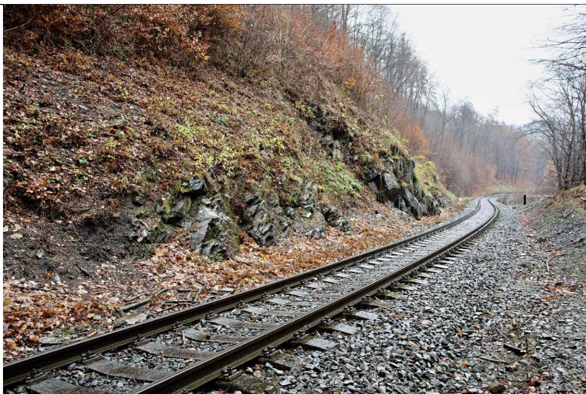
Obrázek 10 Km 16,900, typický stav traťového úseku: kolejový rošt s pražci SB5 s rozponovým upevněním, skalní výchozy a chybějící odvodnění trati.
