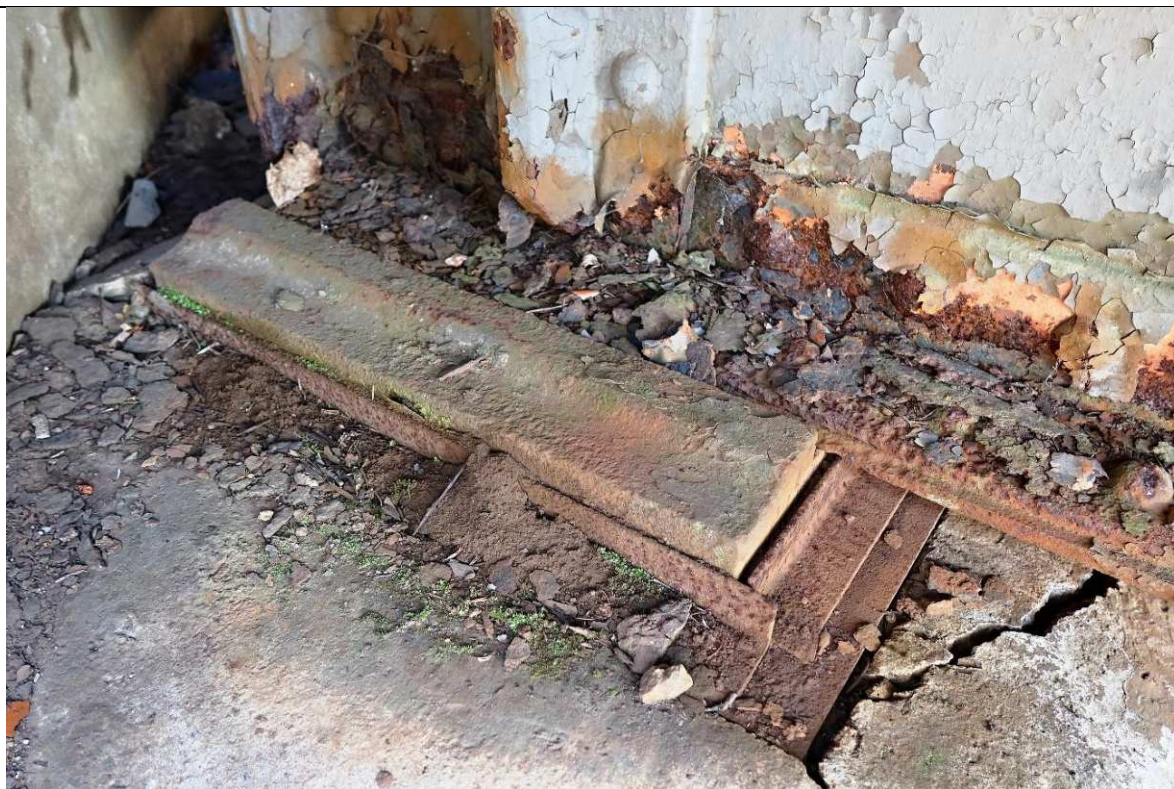
Obrázek 18 Most ev. km 18,902, ložiska a ocelová konstrukce poškozené korozí a úložný práh na opěře s trhlinami.
