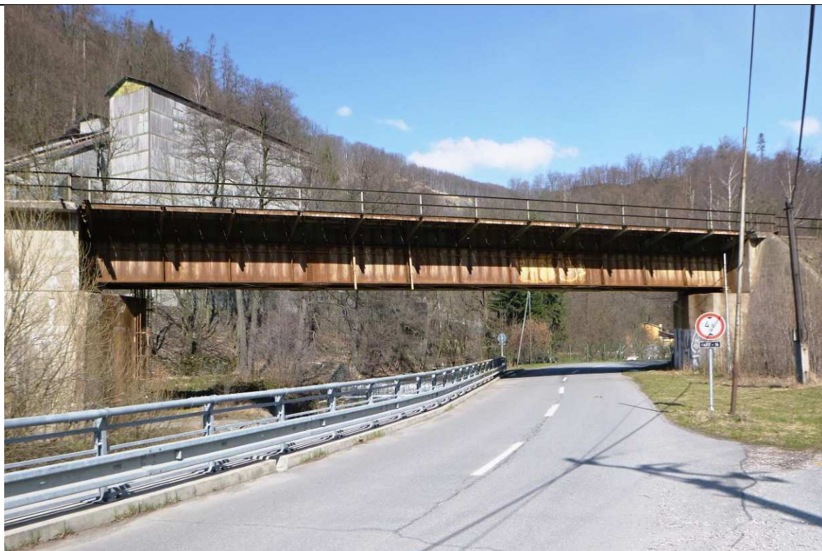
Obrázek 12 Most ev. km 17,580, pohled zprava. Trámová ocelová konstrukce z r. 1981 s přímo pojížděnou konstrukcí, navržena k sanaci.
