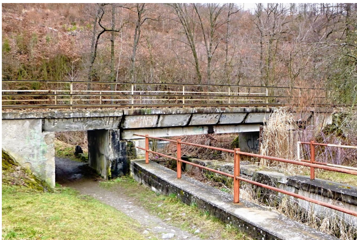
Obrázek 1 Most ev. km 12,836, pohled zprava. Konstrukce z r. 1970, pole vlevo železobetonová deska s obnaženou korodující výztuží, návrh náhrady za novou konstrukci. Pole vpravo předpjaté betonové komorové nosníky, určeno k sanaci.
