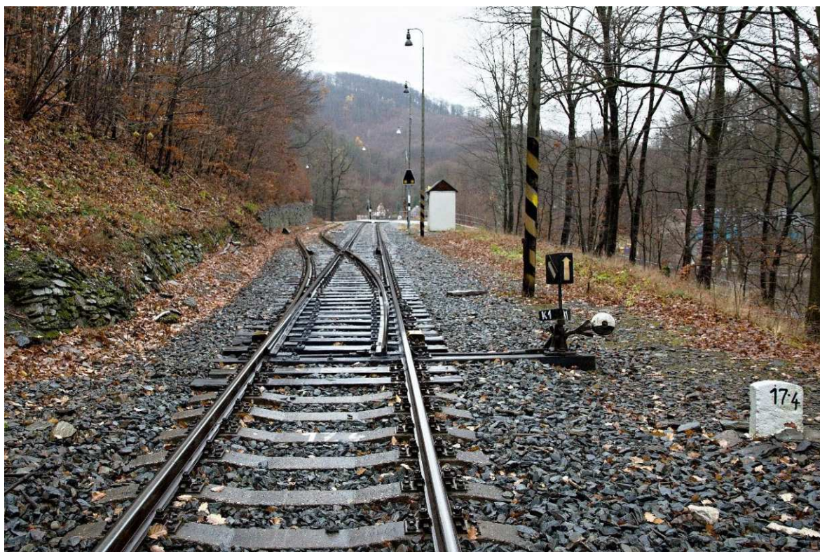
Obrázek 11 Km 17,400, výhybka K1 připojující vlečku ZAPA beton a. s. V pozadí přejezd P7534 zabezpečený PZS na účelové komunikaci do kamenolomu, který je po rekonstrukci.
