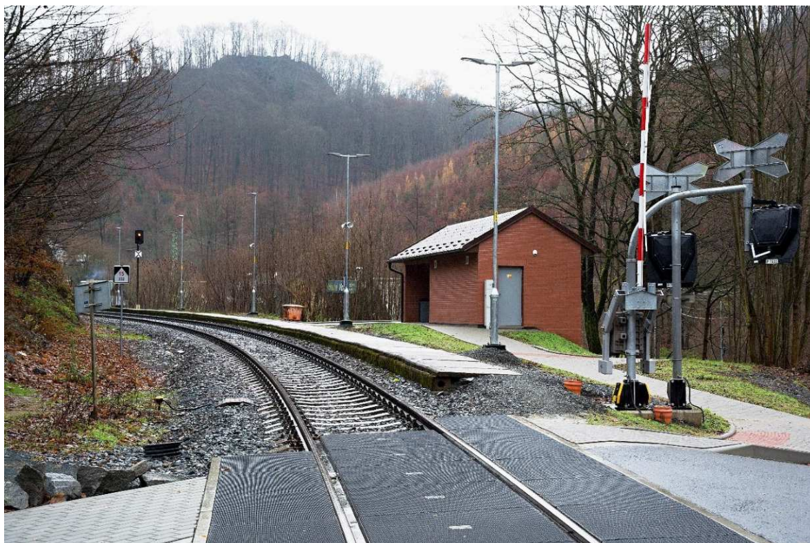
Obrázek 13 Přejezd P7535 s PZS po rekonstrukci v r. 2014, za ním zastávka „Hrubá Voda zastávka“ s přístřeškem (rozšířený technologický domek) a osvětlením. Vlastní nástupiště nemá hmatové prvky, výška je proměnná – navrženo k rekonstrukci na výšku 380 mm.
